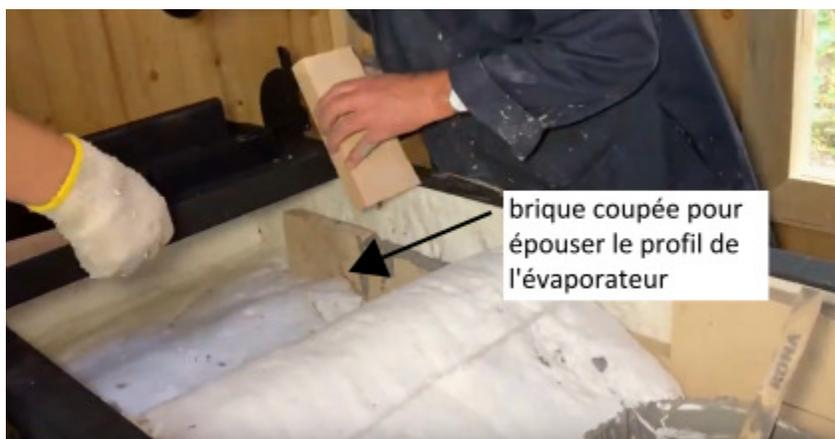
Si vous utilisez la brique de 2'' ½, la dernière brique dans le haut de la chambre de combustion doit être coupé en angle afin de dégager le dessous de la panne pour le transfert de chaleur. Cela n'est pas nécessaire pour la brique de 1'' ¼.
