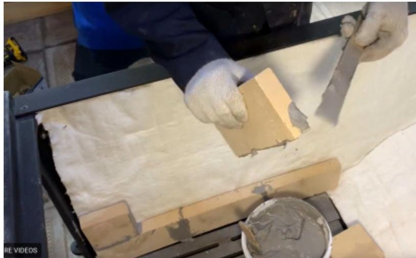
Le briquetage doit être fait de façon perpendiculaire au sol (droit). Lorsque le ciment sera séché et pris, on pourra alors incliner la paroi afin qu'elle vienne s'accoter sur la paroi interne de l'évaporateur. Laisser un espace d'environ 1/4" entre la dernière rangée de briques et le rebord de l'évaporateur
