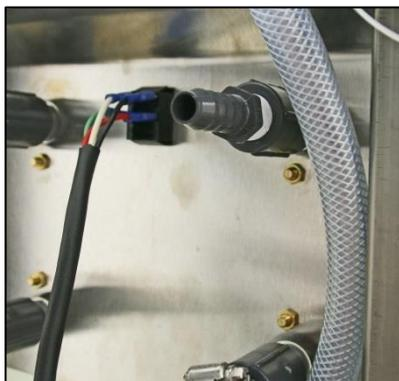
1. Fixer avec du ruban téflon l'extrémité filetée d'un adaptateur plastique-fer en PVC de".
