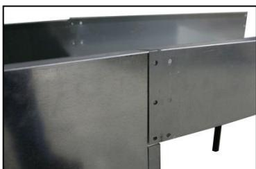
4. Alignez provisoirement le plateau avec l'arche en plaçant le fond du plateau sur la bride du panneau inférieur et les côtés du plateau sur les côtés de l'arche.
